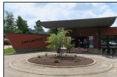
Foyer de vie et Foyer d'accueil médicalisé « Les Lauriers » à Bosc-le-Hard
